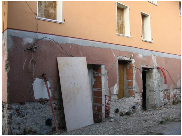
Foto 2: Edificio in esame
