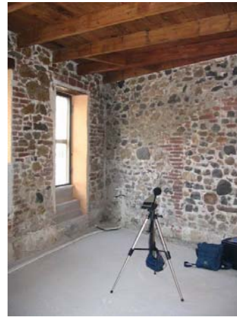
Foto 4: misurazione potere fonoisolante, camera ricevente al piano terra
