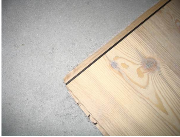
Foto 7: misurazione livello di rumore di calpestio con parquet flottante
