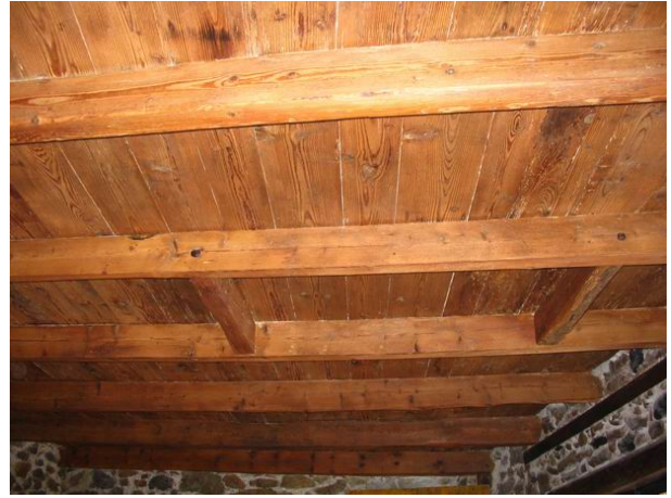
Foto 8: misurazione livello di calpestio, vista solaio dalla camera ricevente
