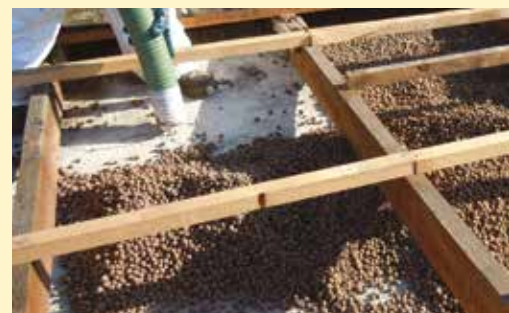
Aspirazione dell'argilla espansa in copertura dopo 30 anni di vita utile per successivo riuso.
