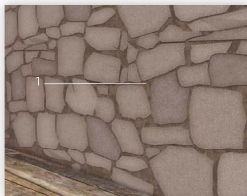
Ristilatura dei giunti.
