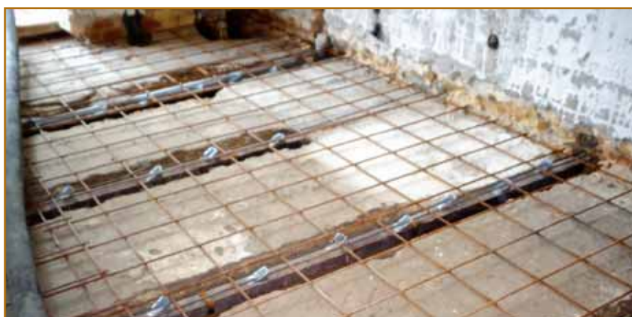
Consolidamento di un solaio in acciaio.
