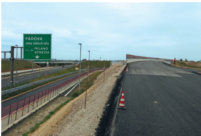
A4-A13 - Rilevato stradale
