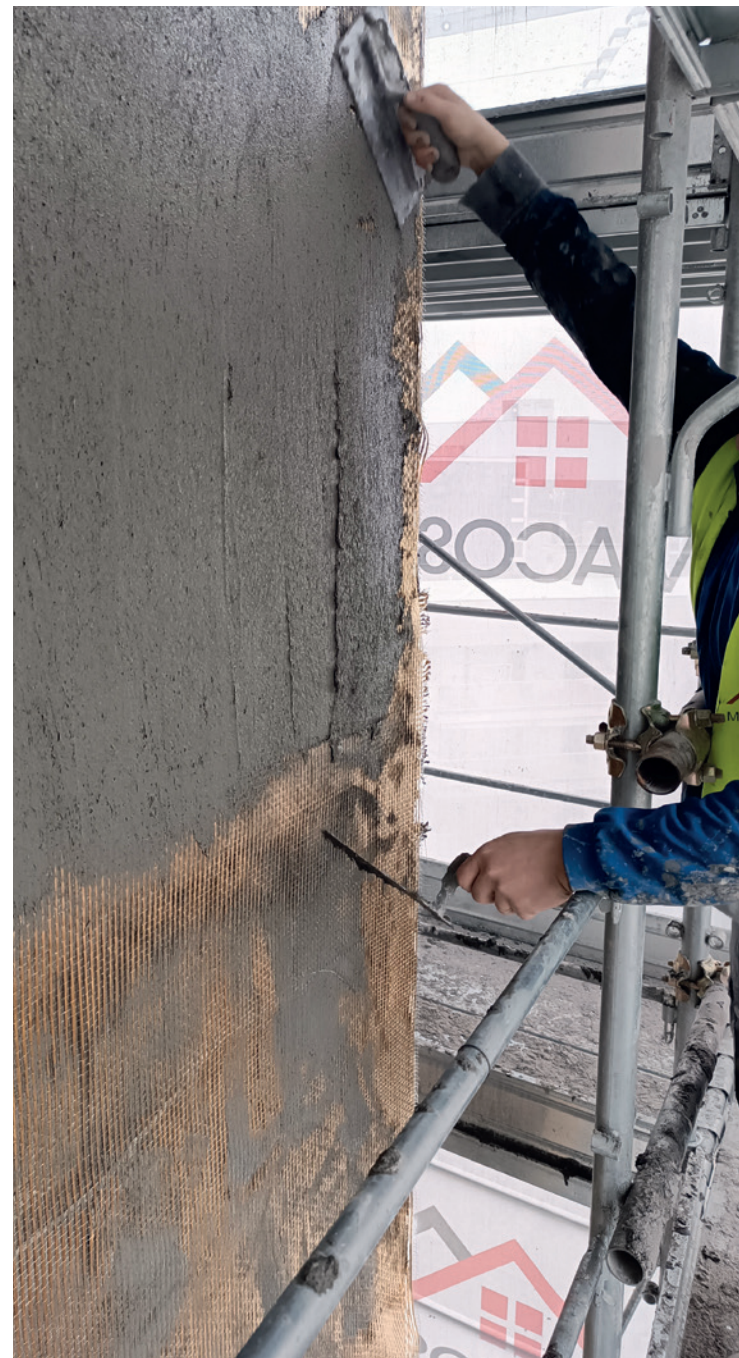
Realizzazione delle fasciature con PBO-MESH 105 e matrice inorganica MX-PBO Calcestruzzo.
