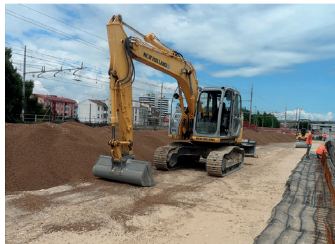
Pescara Porta Nuova - Rilevato ferroviario
