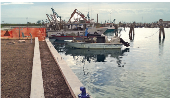
Ampliamento banchina porto di Goro (FE).
