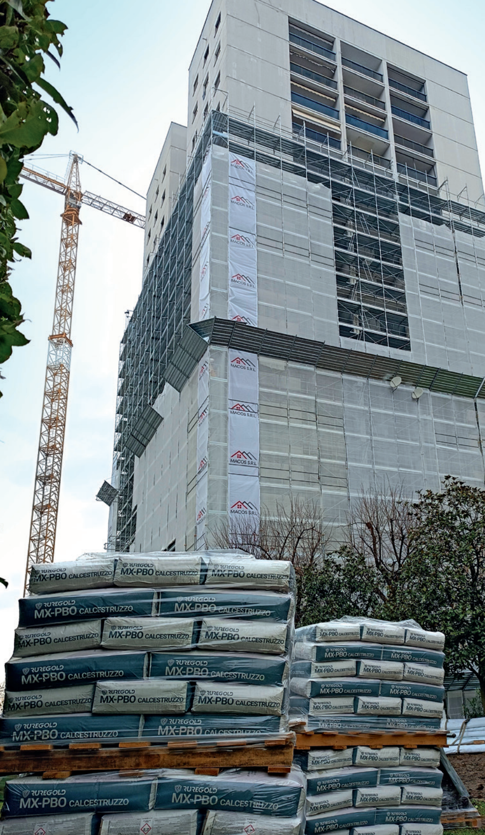
Realizzazione delle fasciature con PBO-MESH 105 e matrice inorganica MX-PBO Calcestruzzo.
