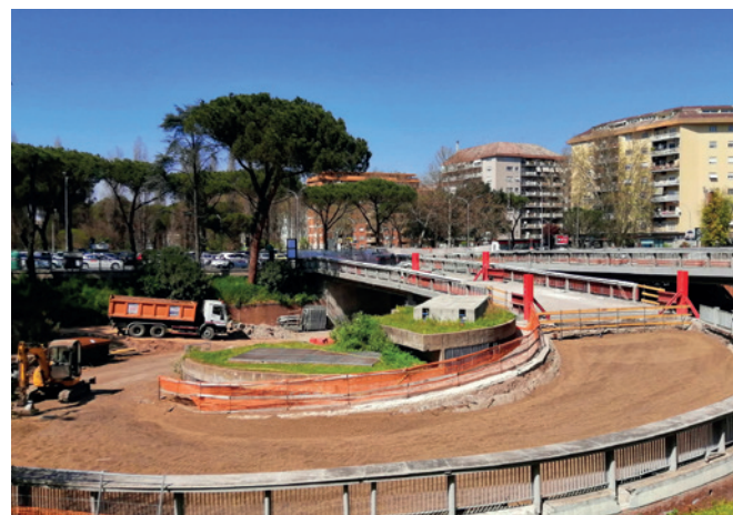
Roma EUR - Rilevato stradale
