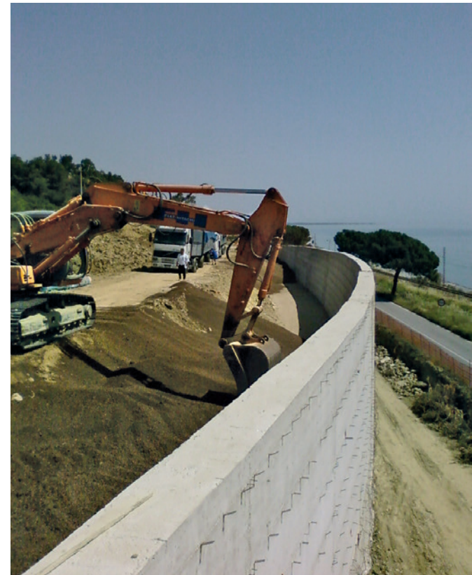
SS 106 Ionica - Riempimento dietro muro di sostegno.
