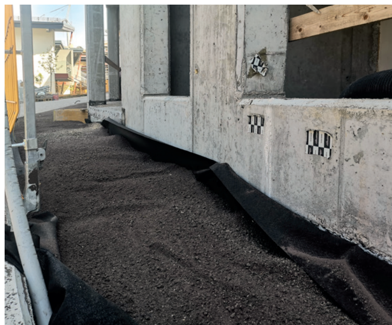
Lo strato drenante è realizzato con argilla espansa Leca 3-8 sfuso.
