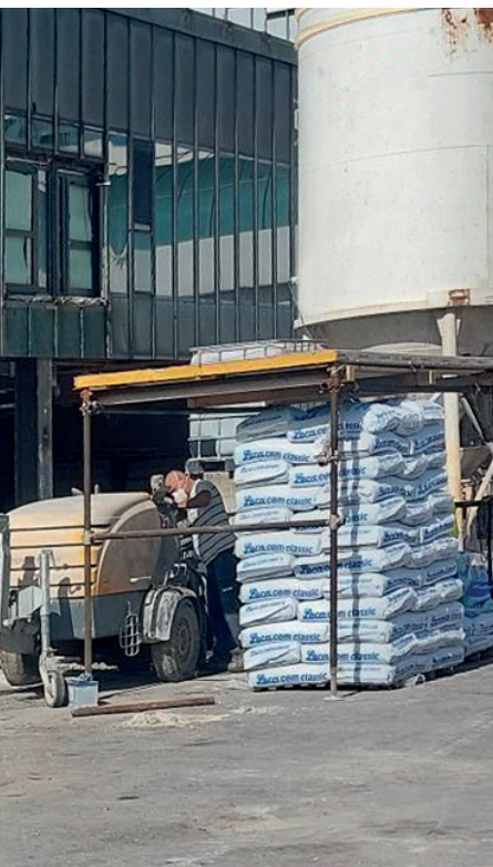
Posa dello strato di alleggerimento in Lecacem Classic, sottofondo leggero a base argilla espansa LecaPiù a grana media e a veloce asciugatura.
