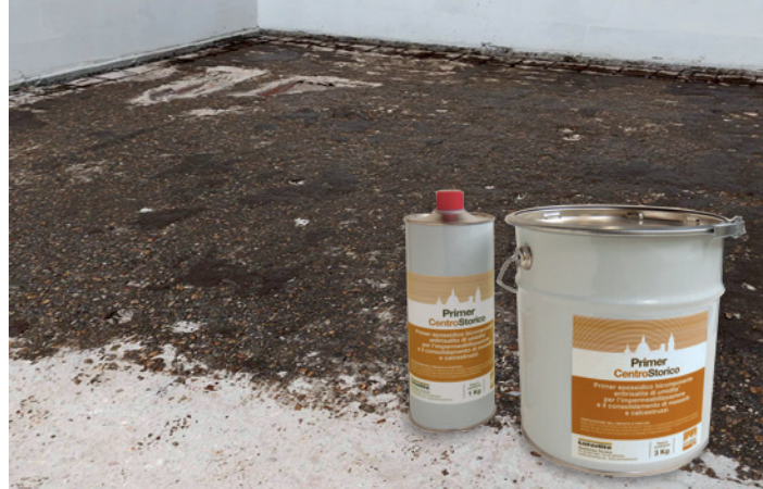
Preparazione del supporto con Primer CentroStorico.
