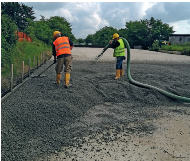
Leca cementata sopra galleria artificiale a Monza.
