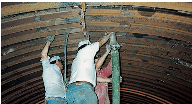
Iniezioni all'intradosso della calotta in galleria sull'Autostrada A30 a Salerno. Anno 2021. • Leca Inject • ReoLeca.
