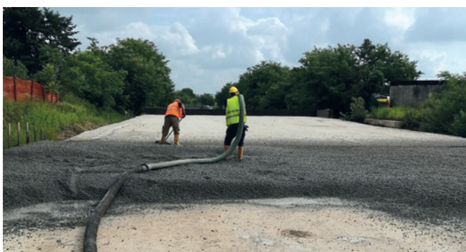
Ritombamento di gallerie artificiali a Monza (MB). Anno 2019 • Riempimento drenante. • Leca 8-20 cementata • Massa volumica 500 kg/m 3 .
