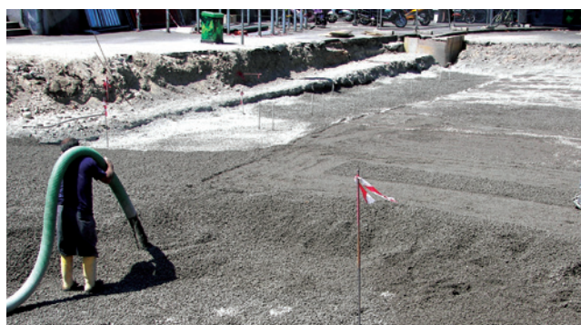
Ritombamento di gallerie artificiali a Monza (MB). Anno 2019 • Riempimento drenante. • Leca 8-20 cementata • Massa volumica 500 kg/m 3 .
