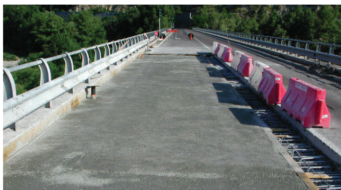
Rifacimento soletta Autostrada A6. • Allargamento a tre corsie Autostrada A14. Anno 2016. Calcestruzzo semi-fluido R_{ck}=40 MPa, massa volumica=1800 kg/m 3 .
