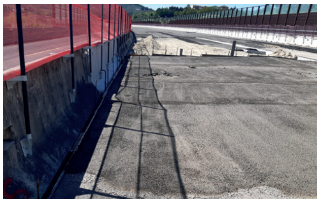
Viadotto lungo l'Autostrada A1 a Firenze Sud. Anno 2021. Misto cementato alleggerito • Massa volumica 1.000 kg/m 3 .
