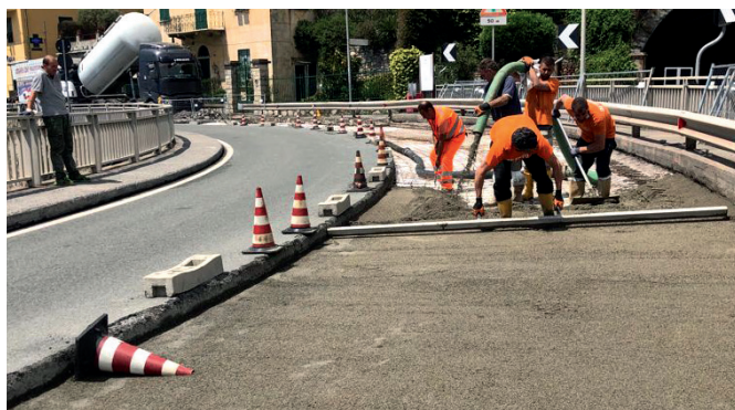
Ponte stradale sulla SS1 Aurelia a Sori (GE). Anno 2021 Leca 2-3 cementato • Massa volumica 800 kg/m 3 .
