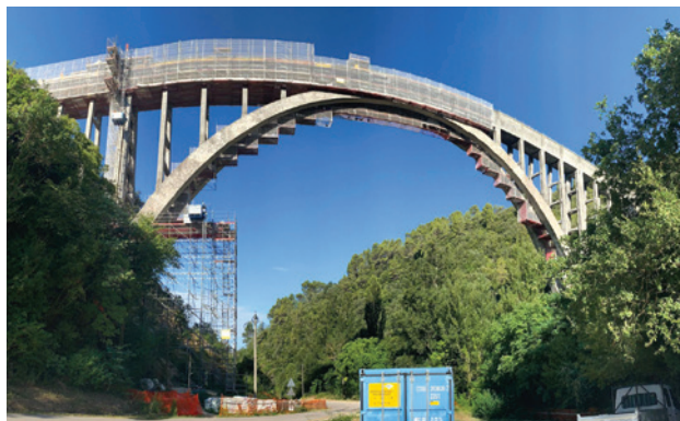
Ringrosso delle travi perimetrali sul Ponte Canale in c.a. Arrone (TR). Anno 2021 Premiscelato LecaCLS 1800 ( R_{ck}=45 MPa, massa volumica=1800 kg/m 3 ).
