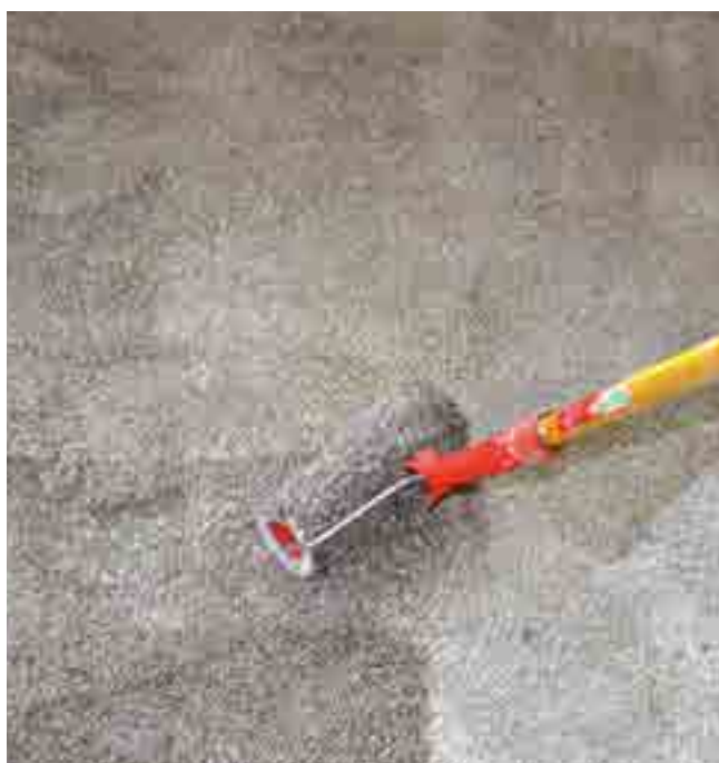
Impermeabilizzazione soletta collaborante in Calcestruzzo CentroStorico.
