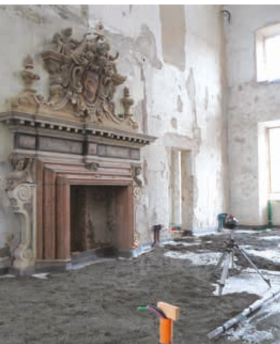
Palazzo Canossa a Mantova: Sottofondo alleggerito a elevata resistenza meccanica Lecacem Mini.
