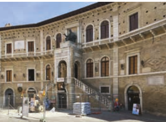
Palazzo dei Priori a Fermo: riempimento di volte con Lecacem Classic e consolidamento strutturale con Leca CLS 1400 e 1800.
