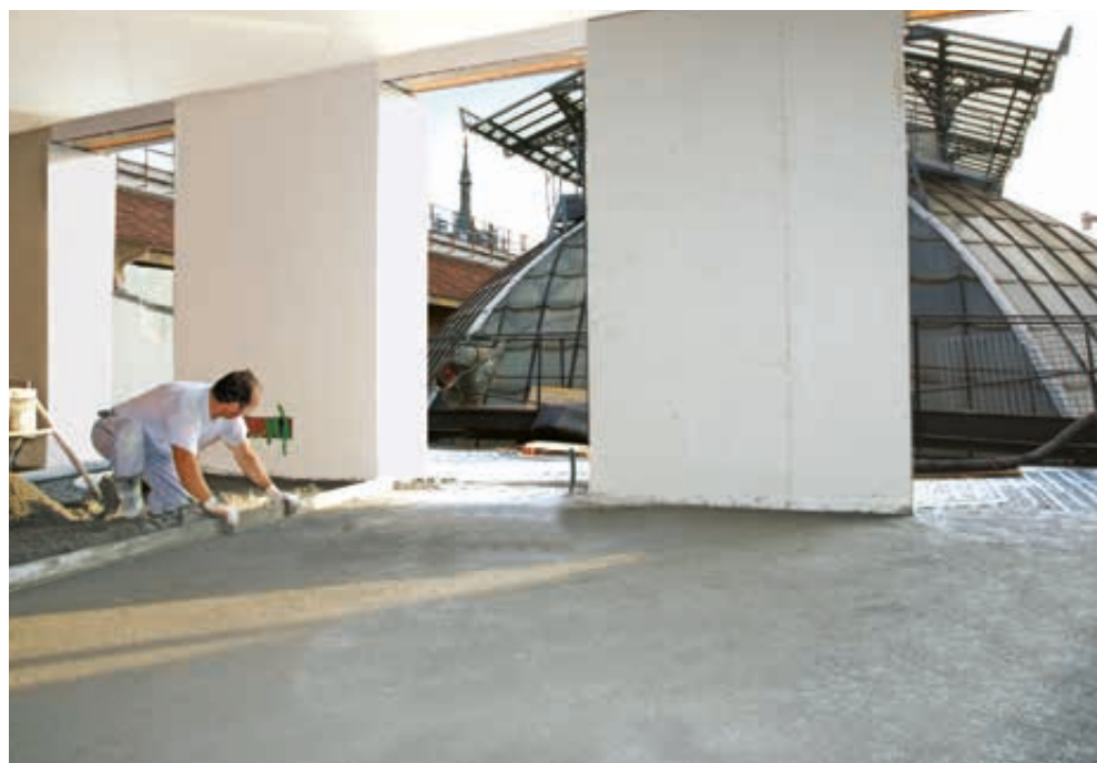
Galleria Vittorio Emanuele a Milano: massetto leggero e isolante in Lecamix Forte.
