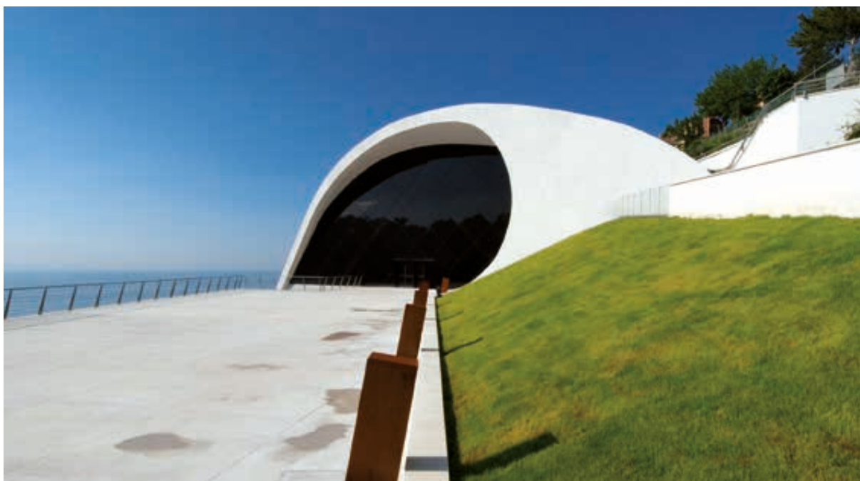
Auditorium Oscar Niemeyer a Ravello, struttura in calcestruzzo leggero strutturale Leca.
