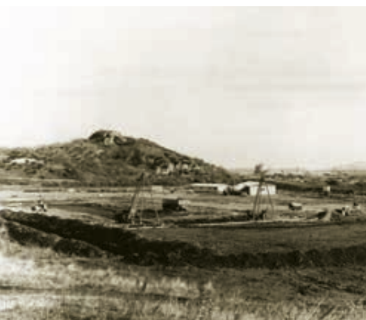
Il cantiere dello stabilimento di Lentella.
