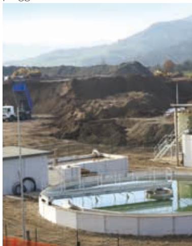
Impianti di trattamento acque di pioggia allo stabilimento di Rubbiano.
