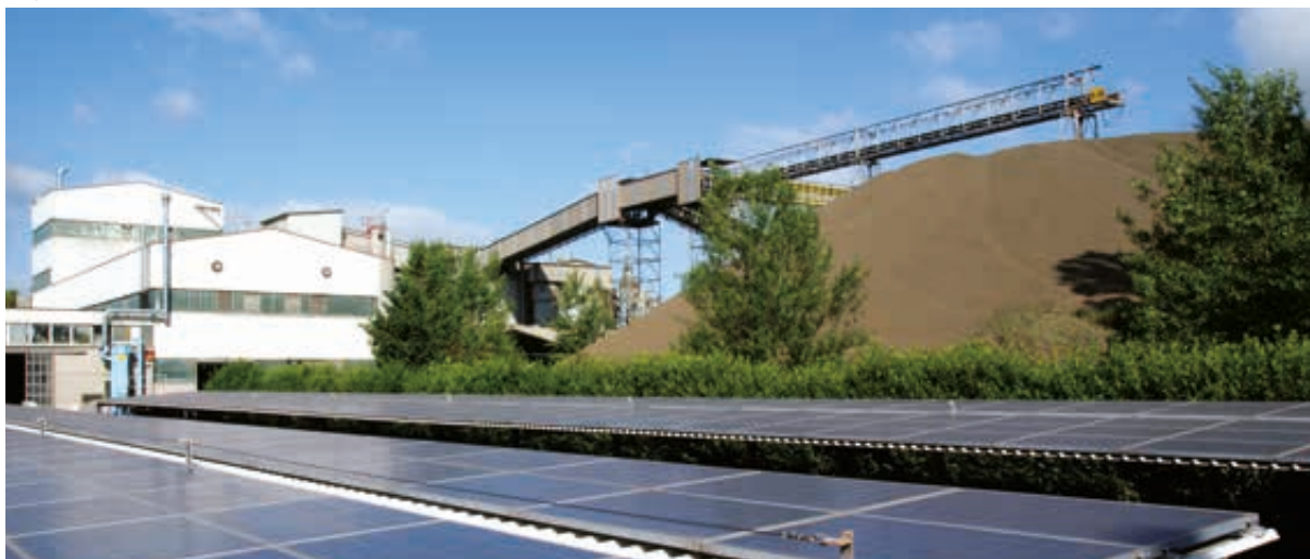
Impianto fotovoltaico nello stabilimento di Rubbiano.
