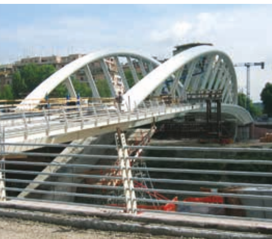
Ponte della Musica a Roma: Calcestruzzo strutturale leggero.
