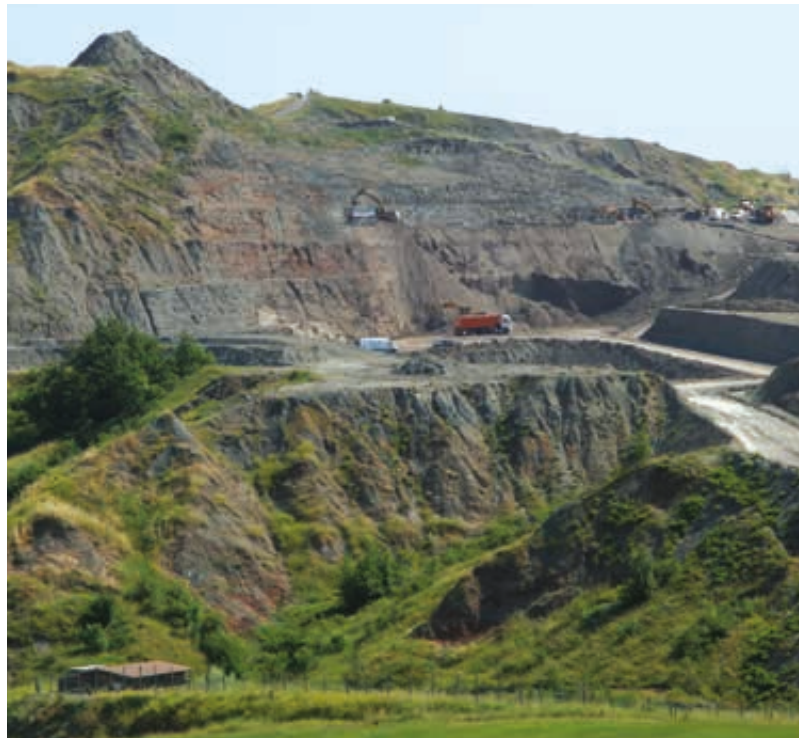
Fase di escavazione (cava Laterlite di Rubbiano).
